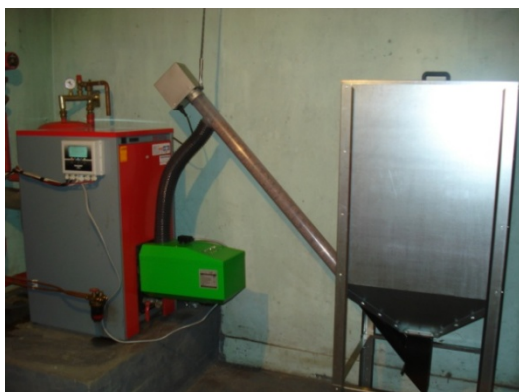
Figura 22 - Queimadores instalados em caldeiras para sistema de aquecimento Fonte: KOSTRZEWA http://www.boilersforpellets.com/files/Obraz%20y/Kocio%20olejowy%20Zaegel%20Heald%20z%20palnikiem%20Platinum%20Bio%20%2016kW.JPG
