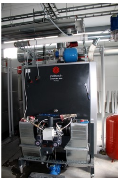
Figura 24 - Queimadores industriais de pellets. Capacidade 700 kW Fonte: pelltech http://www.pelltech.eu/media/uploads/poleti_jpg_versions/thumbnail_poleti.jpg
